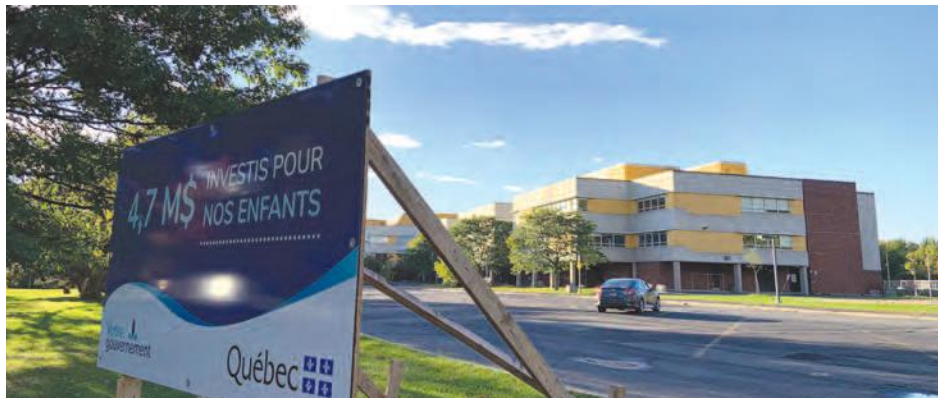
L'école secondaire du Mont-Bruno est en pleine période de travaux. (Photo : archives)
