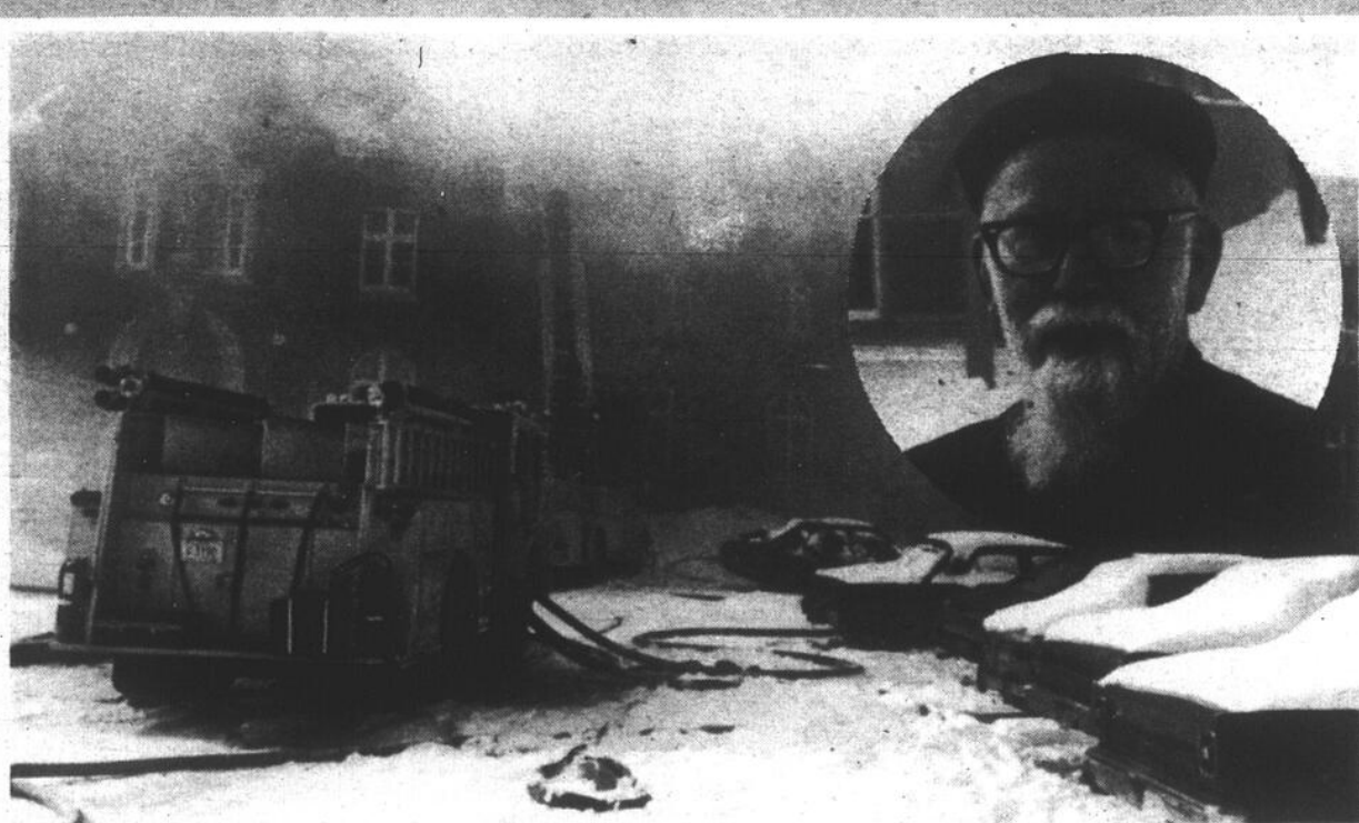
Les flammes ont endommagé un pavillon de la chapelle de la Réparation.
