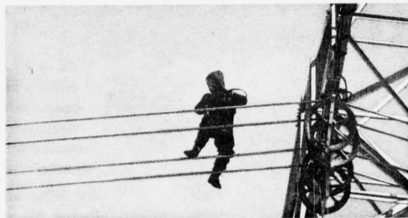
CÂBLE DE TRANSPORT D'ÉNERGIE électrique tressé par l'Alcan à Shawinigan pour les très longues portées au-dessus des cours d'eau entre Manicouagan et Montréal. Le câble d'électricité Alcan est utilisé au Canada et dans une trentaine d'autres pays.
