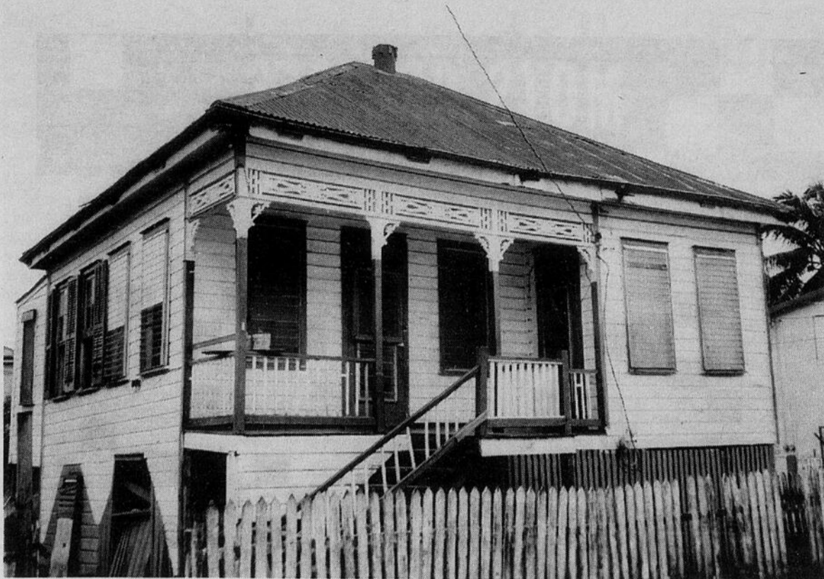
Maison de bois typique sur pilotis à Belize City
