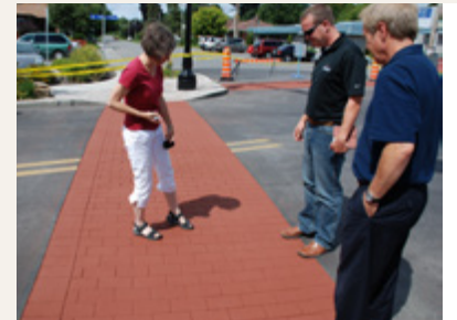
TRAVERSE PIÉTONNE AVEC AVANCÉE DE TROTTOIR ET ASPHALTE COLORÉE
