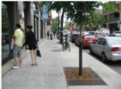
RÉAMÉNAGEMENT DU BOULEVARD SAINT-LAURENT
