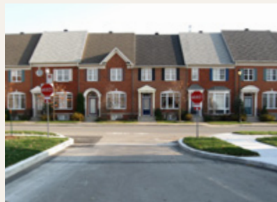
AVANCÉE DE TROTTOIR
