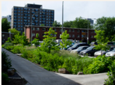
STATIONNEMENT AVEC BASSIN DE RÉTENTION DES EAUX DE PLUIE AUX HABITATIONS JEANNE-MANCE
