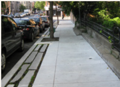
TRANCHÉE PERMETTANT LA PERCOLATION DES EAUX DE PLUIE, RUE SAINT-VIATEUR
