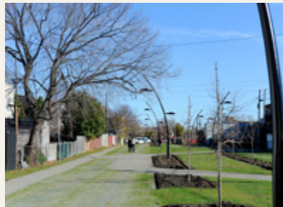
RUE DE TYPE WOONERF: SAINT-PIERRE (SUD-OUEST)
