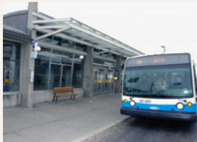
MARQUISE VITRÉE AU TERMINUS HENRI-BOURASSA
