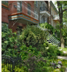
RECU DE FAÇADE VÉGÉTALISÉ
