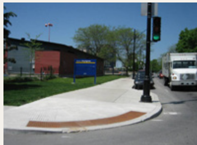
BATEAU PAVÉ MUNI DE DALLES TACTILES
