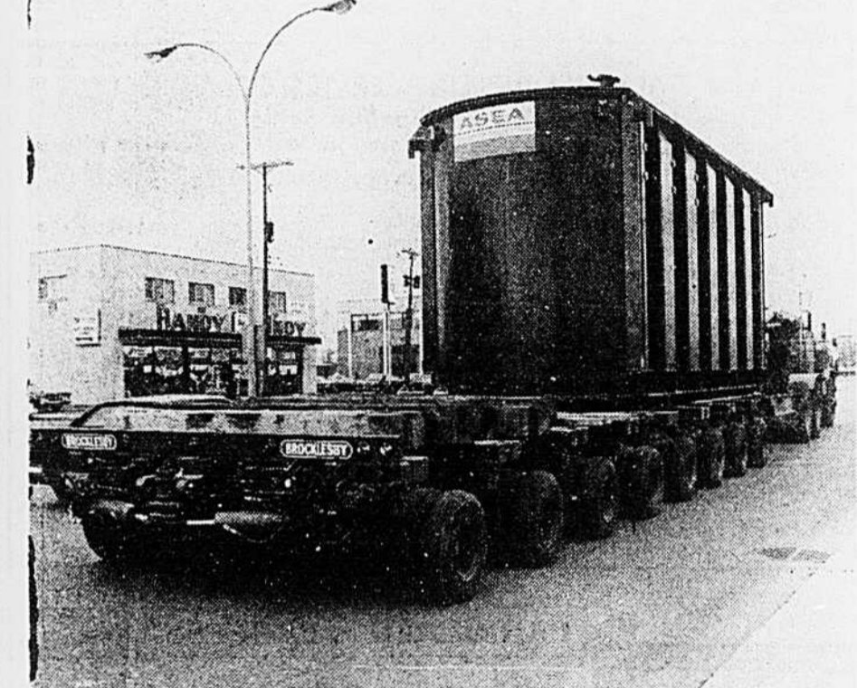
Une remorque exceptionnelle Le plus grand véhicule routier du Canada, une remorque surbaissée munie de 64 roues appartenant à la Brocklesby Transport, a entrepris un voyage initial ces jours-ci lorsqu'il transporta un transformateur destiné à la sous-centrale de la Vérendrye de l'Hydro-Québec d'une voie ferroviaire, à Ville LaSalle, une distance de deux milles. Une suspension hydraulique assure la répartition égale de la charge sur toutes les roues. La remorque, sur cette photo, avance le long du boulevard Dollard à Ville LaSalle.
