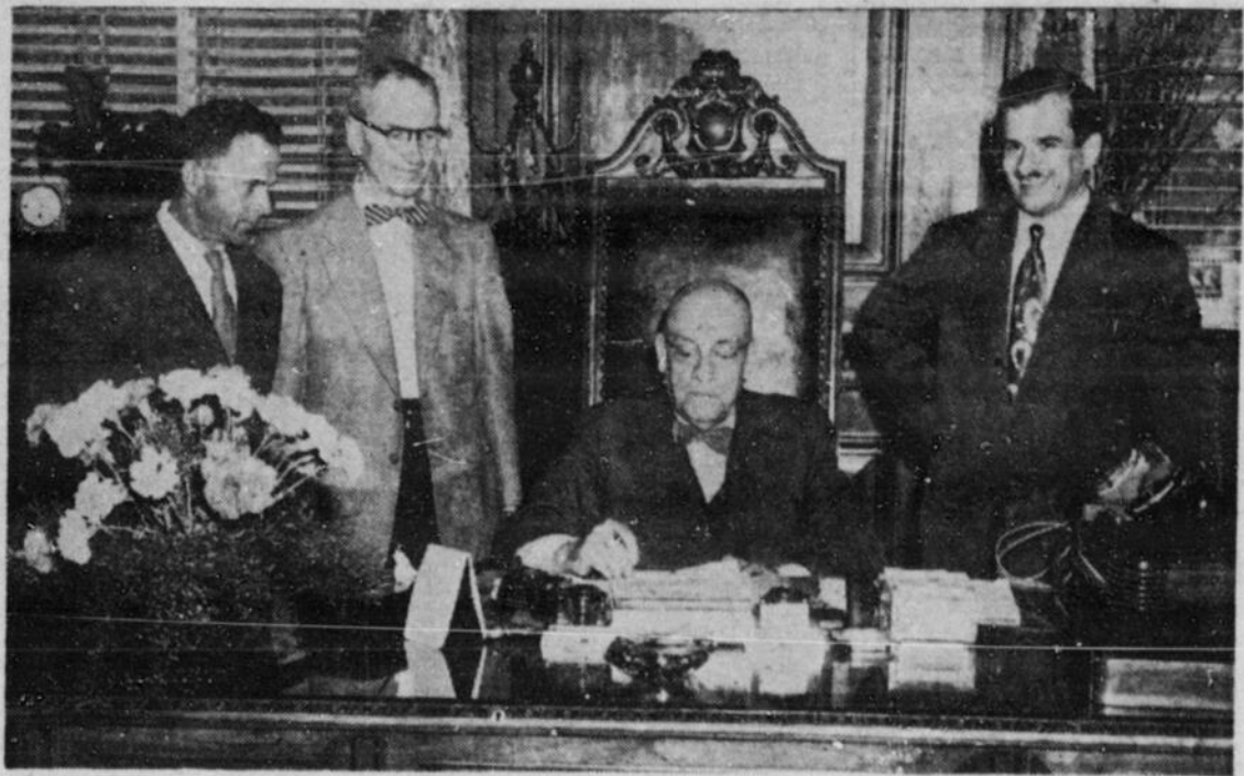
LE CONTRAT en vertu duquel la ville de Montréal cède un emplacement à la Compagnie du marché central métropolitain Limitée pour l'établissement d'un marché central de gros dans le nord de la métropole a été signé dans les bureaux de la mairie. Sur la photo, de gauche à droite, avec le maire Houde qui vient de signer pour la ville: MM. Adrien Moquin, président de la compagnie; le notaire L.-A. Marchessault, qui a rédigé le contrat, et Alphonse Couture, secrétaire-trésorier.
