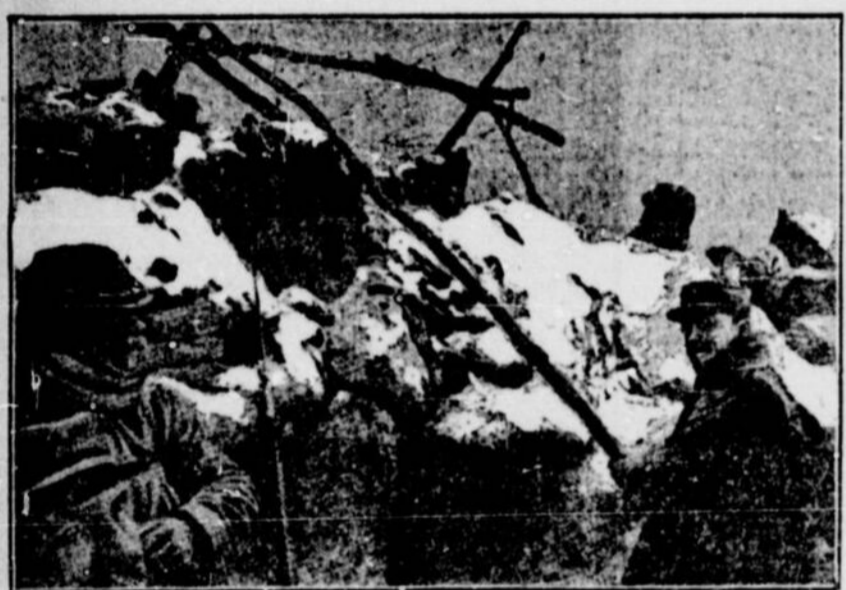
CHEVAL-DE-FRISE FAIT DE BRANCHAGES ET GARNI DE RONCES ARTIFICIELLES— Cette défense accessoire a été construite hâtivement par nos hommes dans la tranchée même et hissée sur le parapet au moyen d'une perche, les défenseurs restant ainsi à l'abri.
