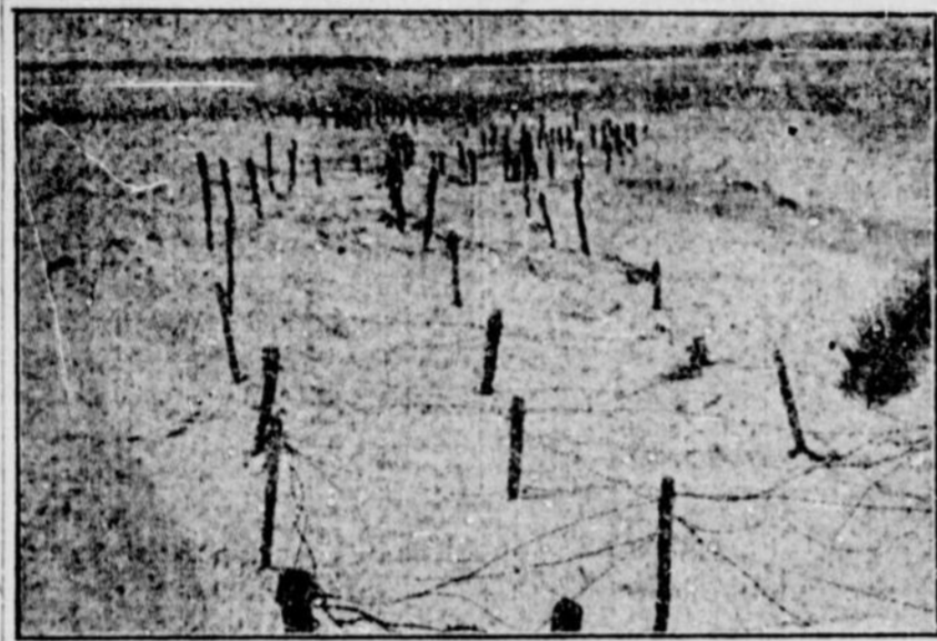
Triple barrage de fils de fer protégeant une tranchée de première ligne.
