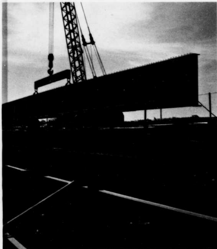
Les poutres imposantes du pont à 12 voies de l'autoroute Macdonald-Cartier sont en tôles d'acier Algoma
