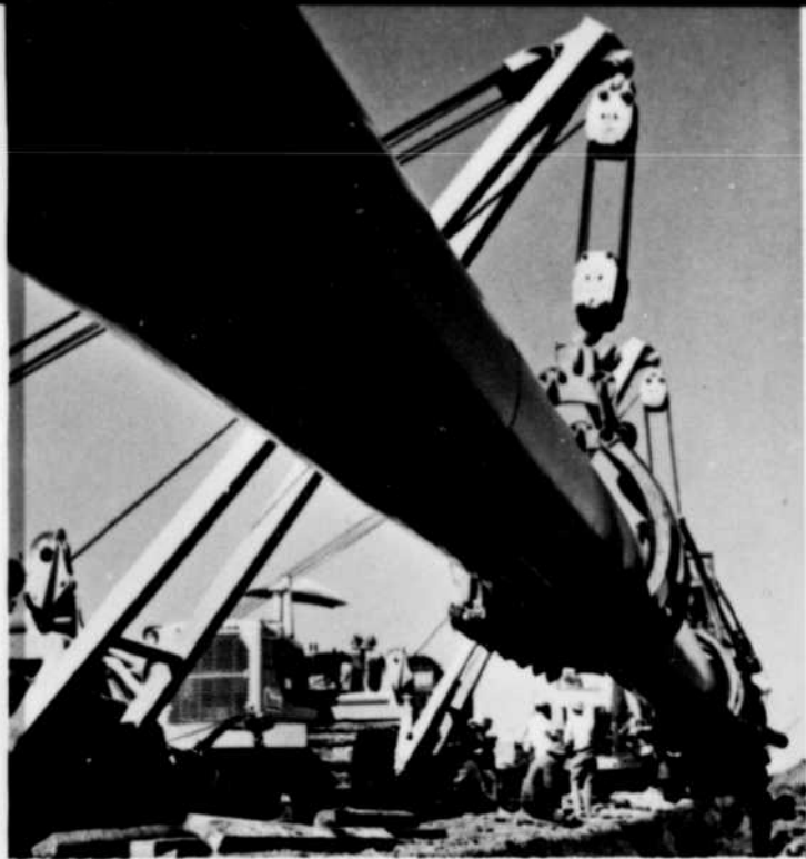
L'Algoma est le principal fournisseur d'acier nécessaire à la fabrication de tuyaux de toutes dimensions allant d'un demi-pouce à une verge de diamètre
