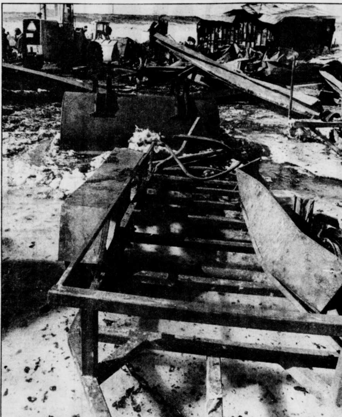
Une cinquantaine d'employés se retrouvent sans travail à la suite du sinistre, rue du Parc, qui laisse derrière lui des dommages évalués à 2 millions $. La cause de l'incendie, qui aurait pris naissance dans une garde-robe, demeure inconnue.
