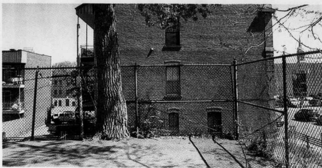
Actuellement réaménagé afin de devenir plus sécuritaire et verdoyant, le terrain, dont l'aspect historique devrait être valorisé, offrira bientôt aux Montréalais une nouvelle aire de détente.
