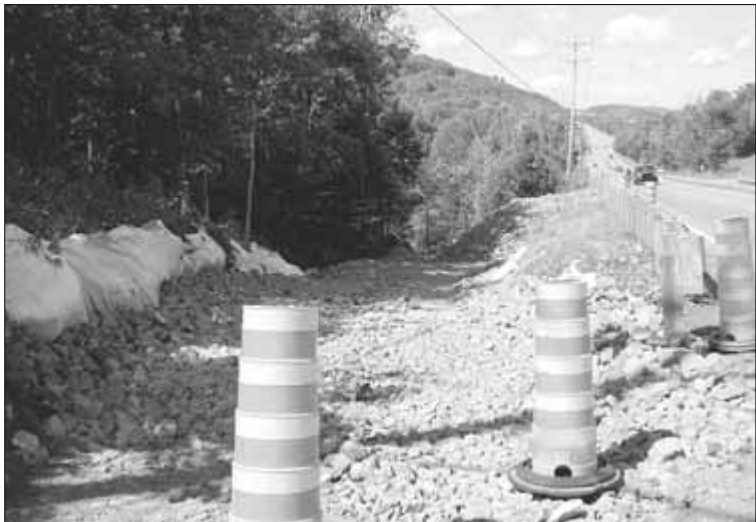
Travaux de réfection pour protéger la route 117 d'éventuels glissement de terrains
