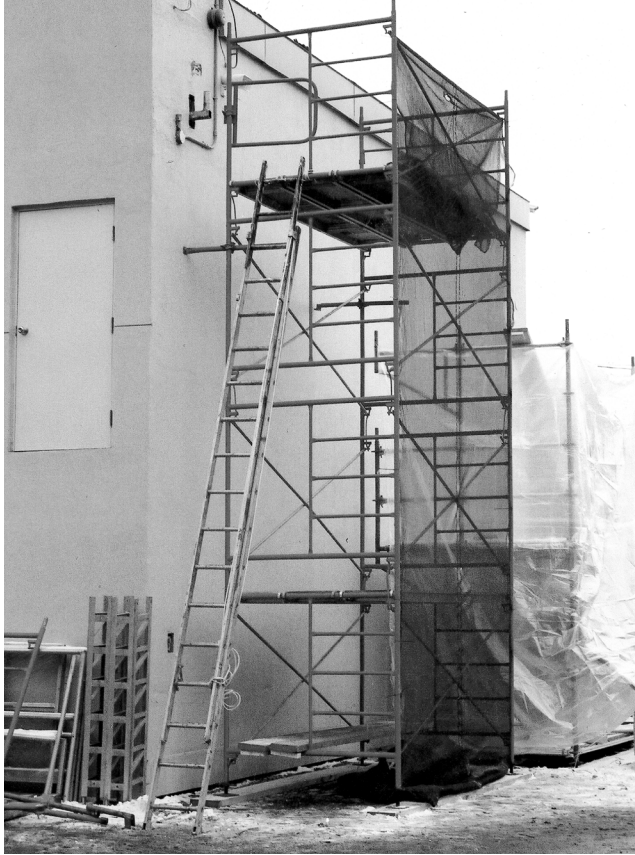
Échafaudage sur cadres métalliques utilisé avec un filet
