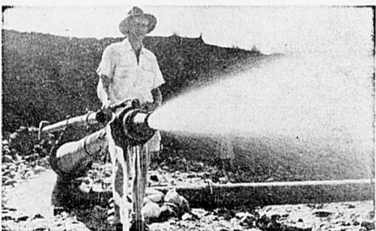
A Boulolo, l'extraction de l'or se faisait par le "lavage".
