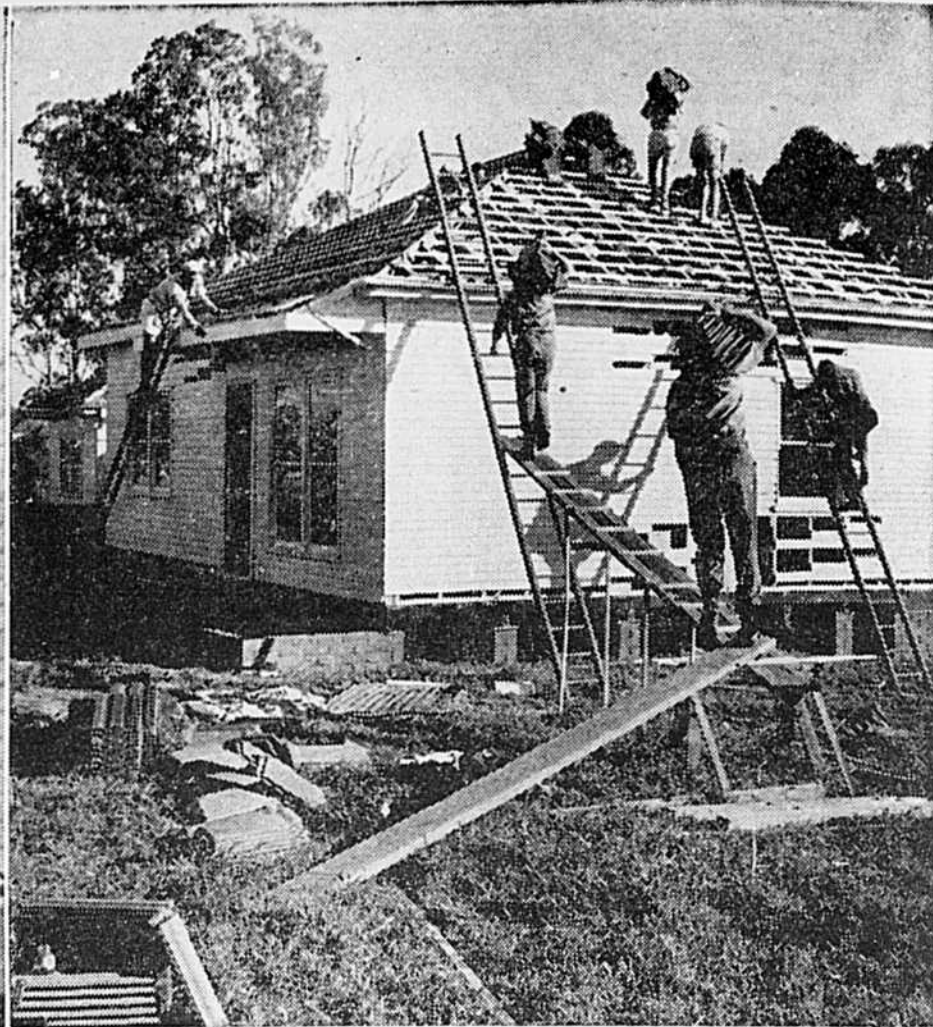
En 24 heures un entrepreneur vous monte une maison. A gauche, les murs terminés. A droite, les derniers travaux.
