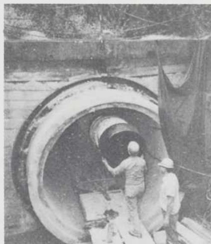
A gauche: Mise en place d'une section de 20 pi. de conduit de tôle d'acier ondulée dans la canalisation en béton de 9 pi. de diamètre. A droite: Les supports du conduit sont scellés au sommet de la canalisation.
