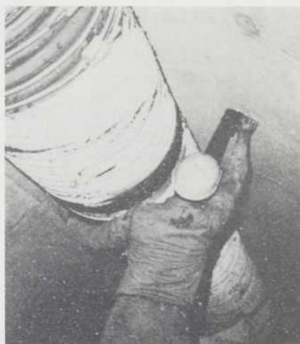
A gauche: Mise en place d'une section de 20 pi. de conduit de tôle d'acier ondulée dans la canalisation en béton de 9 pi. de diamètre. A droite: Les supports du conduit sont scellés au sommet de la canalisation.
