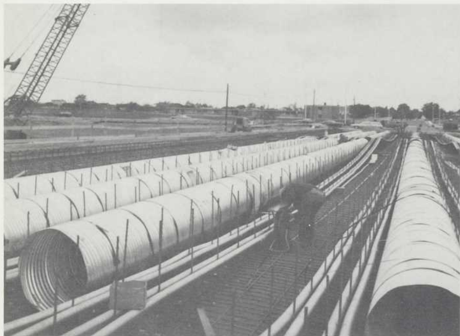
Un des ponts en construction. Les câbles de tension sont déposés le long des tuyaux qui formeront des vides dans la dalle.
