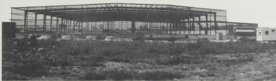
L'entrepôt Stran-Steel de Consumers Glass Co. couvre six acres, à Milton (Ont.).
