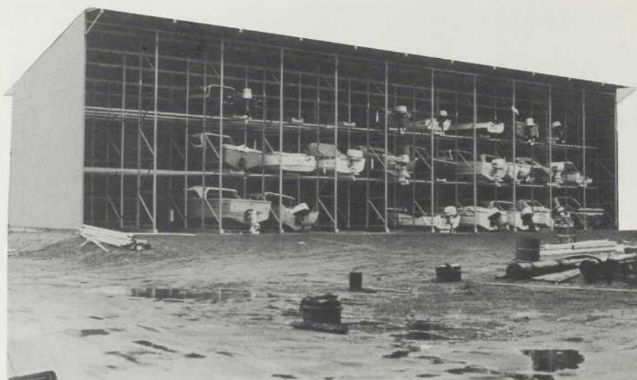
Hangar de remisage de bateaux dans le nord de l'Ontario.
