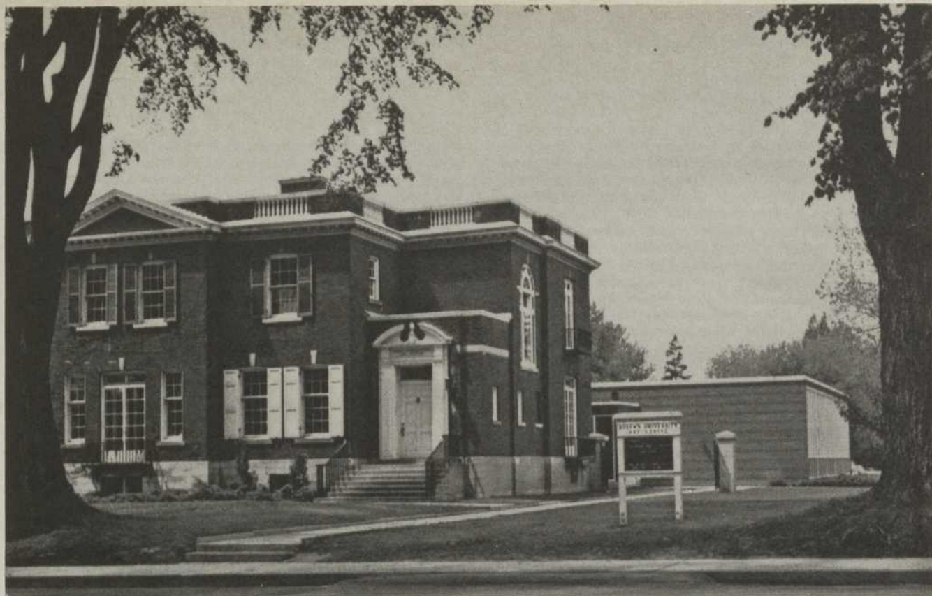
La maison de style georgien qui forma la première partie du centre en 1957.
