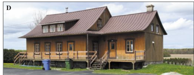
Photo : Denis Bécharde #190529_0078 La maison peu de temps avant sa démolition. Sur le socle de la croix de chemin, on pouvait lire :
