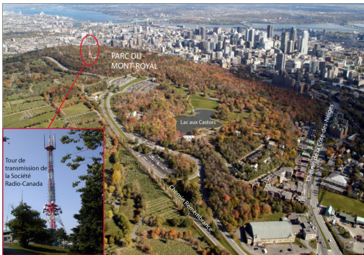
Figure 1 : Localisation géographique de la tour de transmission de la Société Radio-Canada dans le parc du Mont-Royal
