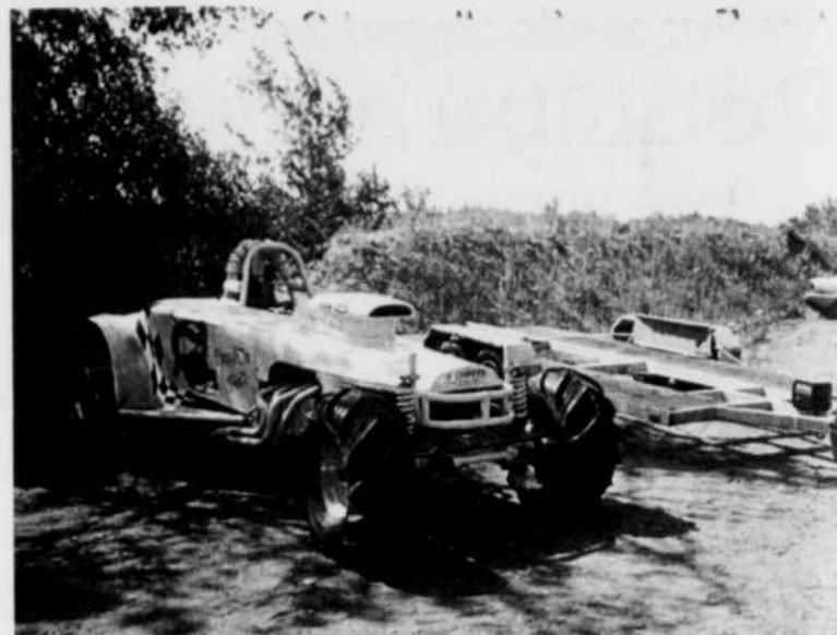
BOUE - Un bolide comme celui-ci dispose d'un moteur développant jusqu'à 1500 «forces», de quoi compléter la distance de 200 pieds, dans 18 pouces de boue, en moins de quatre secondes.
