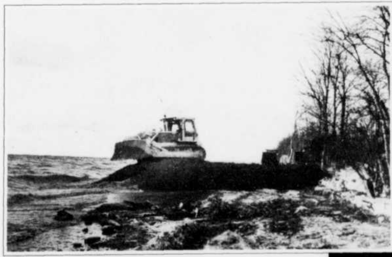
Les travaux se poursuivront en 1987. On en profitera pour compléter ce qui n'a pu l'être en 1986.
