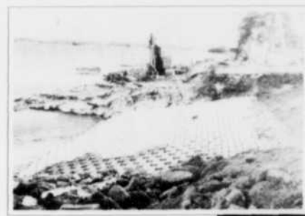
Des blocs de type terrafix ont été installés afin de protéger les berges et de faciliter l'accès au lac, là où la situation le justifiait.
