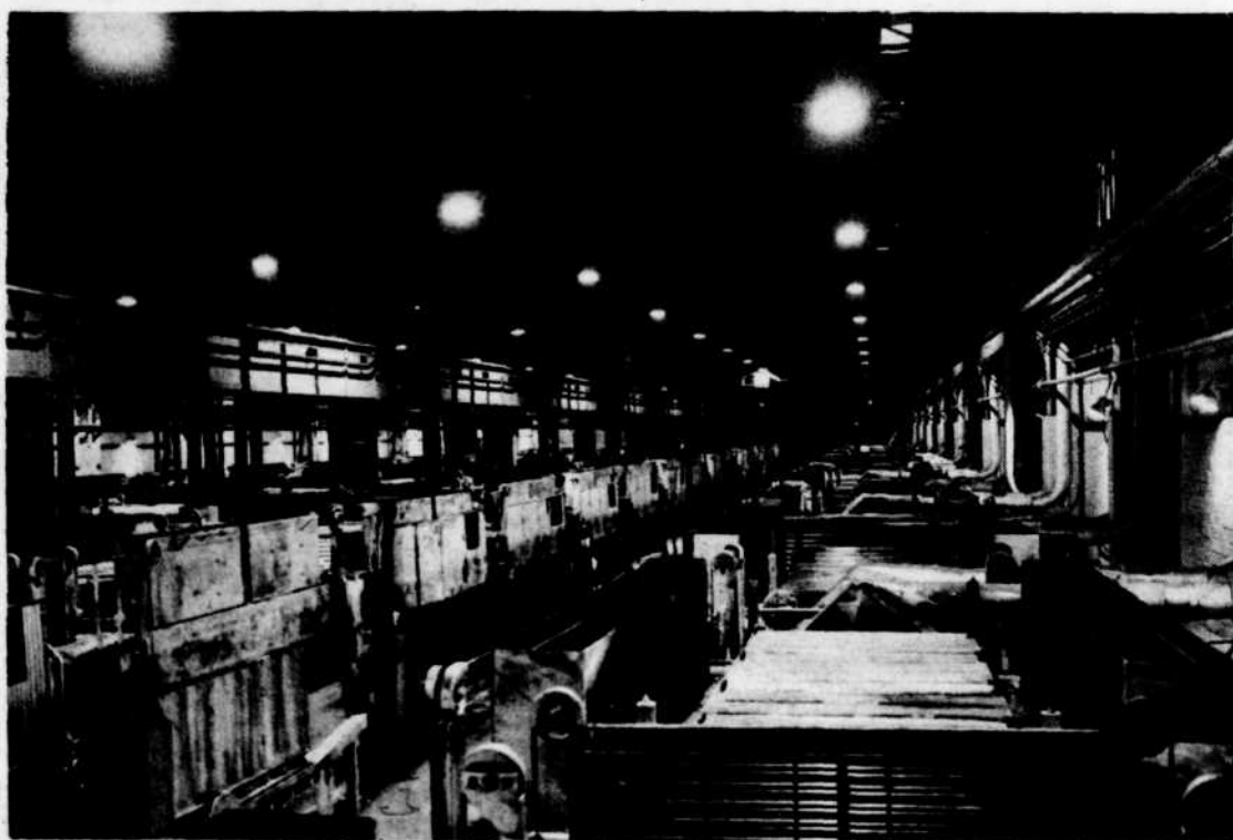
LA SALLE DE CUVES 52 est l'une des salles d'électrolyse des usines Alcan d'Arvida qui furent dotées de luminaires Wide Light avec lampes au mercure. On note qu'aux murs latéraux un éclairage additionnel
