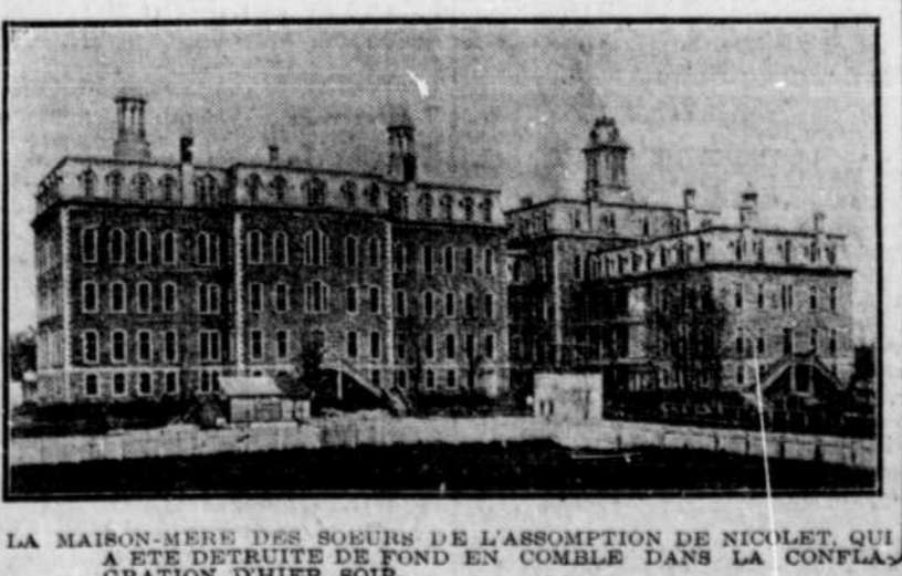
LA MAISON-MERE DES SOEURS DE L'ASSOMPTION DE NICOLET, QUI A ETE DETRuite DE FOND EN COMBLE DANS LA CONFLAGRATION D'HIER SOIR.
