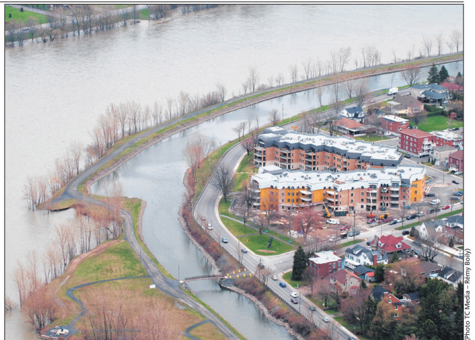
En 1979, une ouverture avait été pratiquée dans la bande du canal, face aux condos. La structure en palplanches d'acier est toujours visible.
