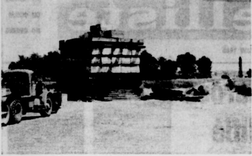
(Photo Le Nouvelliste) CET INTRIGANT TAS DE PIERRE empilé sur le site du futur pont n'est pas la base du premier pilier. Il s'agit plutôt de la seconde phase des expériences de la compagnie Franki. Au cours des semaines dernières, un pieu de quelque 130 pieds a été enfoncé. Maintenant sur cette base, les ingénieurs ont fait disposer une importante charge afin d'étudier ses réactions dans le genre de sol que l'on trouve sur les lieux.
