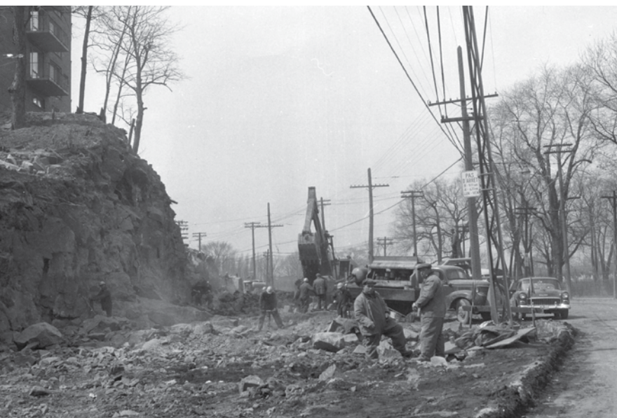
Entre 1957 et 1959, on procédait aux derniers travaux d'élargissement du chemin de la Côte-des-Neiges, à Montréal.
