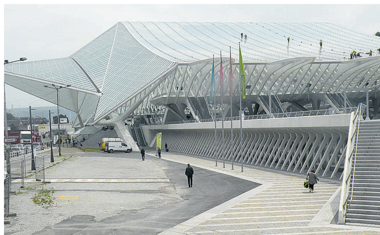
La gare des Guillemins, œuvre de l'architecte espagnol Santiago Calatrava, fait beaucoup jaser. — PHOTO COLLABORATION SPÉCIALE ANDRÉ DÉSIRONT
