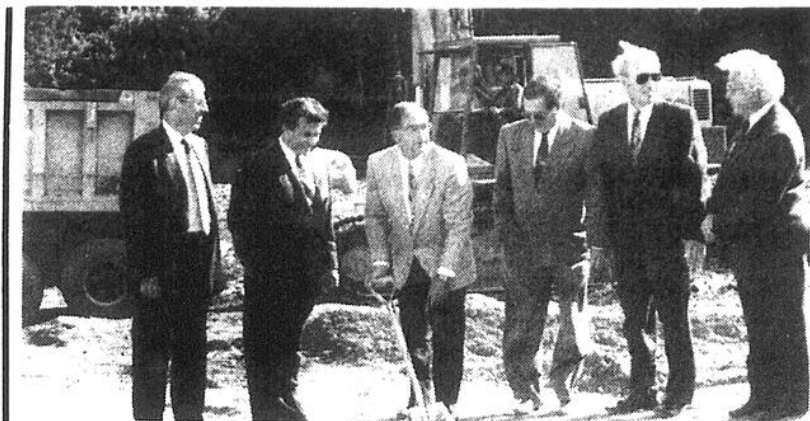
C'est le maire de La Pocatière, André Théberge, qui a procédé à la première pelletée de terre du Centre de services McDonald's/Ultramar.
