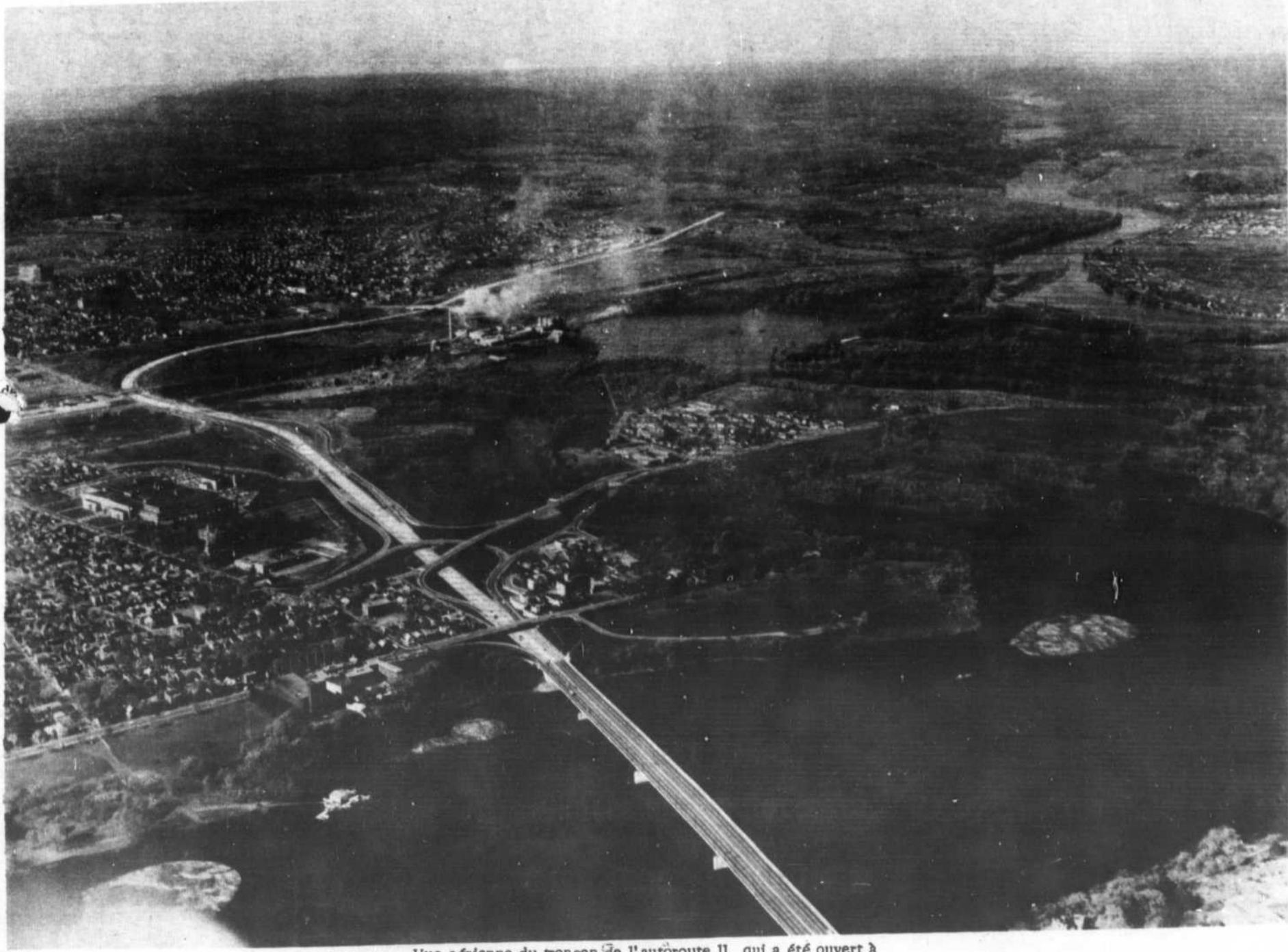
Vue aérienne du tronçon de l'autoroute 11, qui a été ouvert à la circulation dans la ville de Hull, jeudi le 26 octobre 1967.
