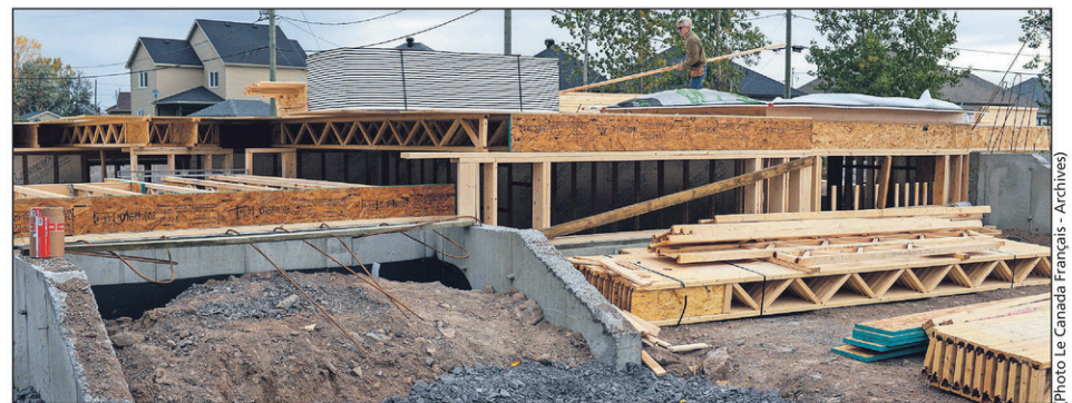
Plusieurs mises en chantier ont été réalisées dans les secteurs Saint-Luc et L'Acadie.
