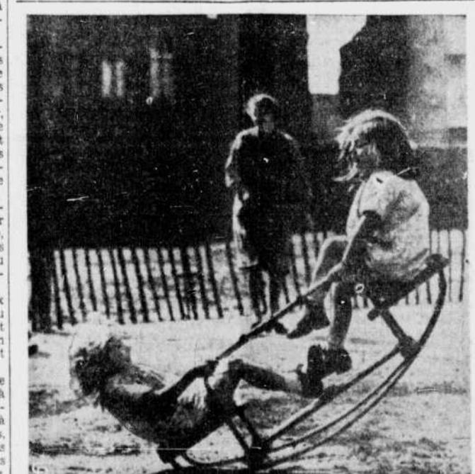
La vie reprend — Avec des squelettes d'édifices à demi démolis comme fonds de décor, les enfants de Londres reprennent leur vie normale dans un parc dont on a fait le déblayage des débris.
