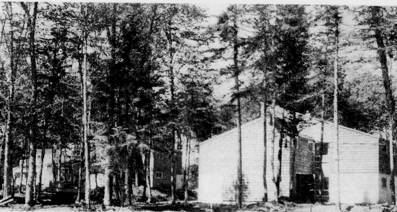
Comme on peut le voir, c'est dans un très beau décor qu'a été construite "La Maisonnée". La photo ci-haut nous montre les deux unités réservées aux garçons. Il s'agit de "La Tabatière" et "Le Chaudron" qui pourront abriter respectivement 35 et 21 garçons. (Photo La Tribune, Thetford Mines)
