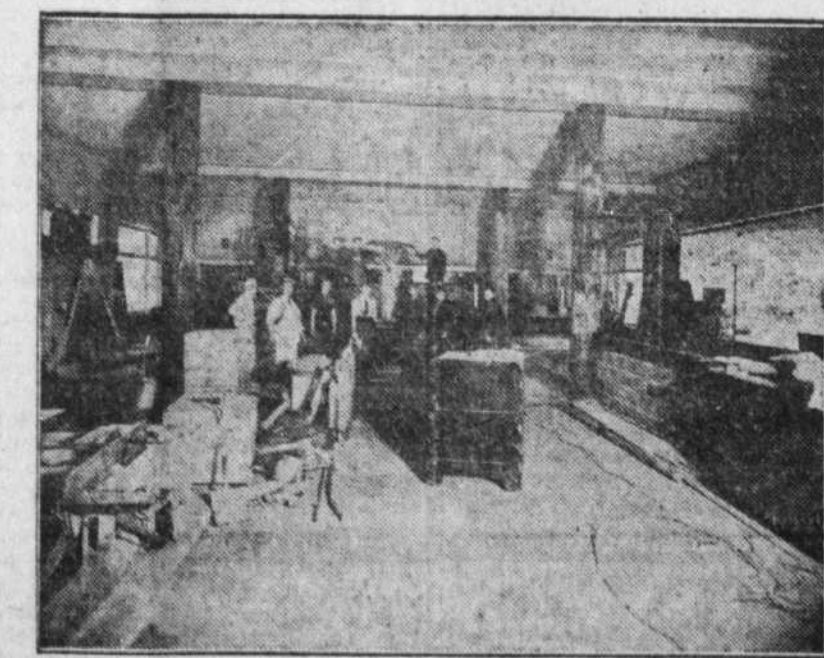
Cette photo, prise vendredi dernier, montre l'intérieur du nouveau terminus de la Provincial Transport Company. Les ouvriers y mettaient la dernière main, car cet imposant immeuble doit être ouvert au public demain. Situé au no 1188, rue Dorchester ouest, angle Drummond, ce terminus, d'architecture moderne et éblouissante de lumière la nuit, constitue de nouvelles facilités de transport pour la métropole.
