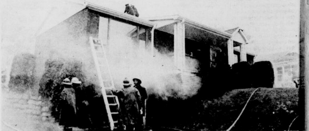
Cette maison, propriété de M. Paul-Eugène Larouche, du 377 rue du Foyer à Chicoutimi a été détruite par les flammes, vendredi matin. On a dû lutter
