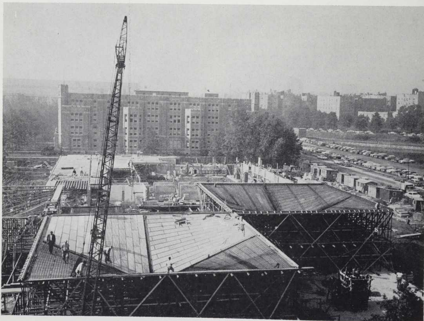
Vue générale du chantier.
