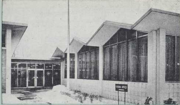
L'entrée et les murs vitrés du nouvel immeuble abritant les bureaux de Parke Davis & Company, à Montréal, sont en acier inoxydable au nickel et ont été fabriqués par Canadian Pittsburgh Industries Limited, de Montréal. Architecte: Paul H. Lapointe. Ingénieur: R. P. Steketee, c/o Giffels & Vallet of Canada, Ltd.
