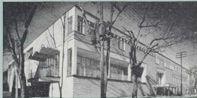
Nouveau gymnase des étudiantes de l'Université de Toronto. Les cadres de fenêtres et les meneaux sont en acier inoxydable au nickel. Fabricant: Cresswell-Pomeroy Ltd. Architectes: Fleury, Arthur and Barclay.
