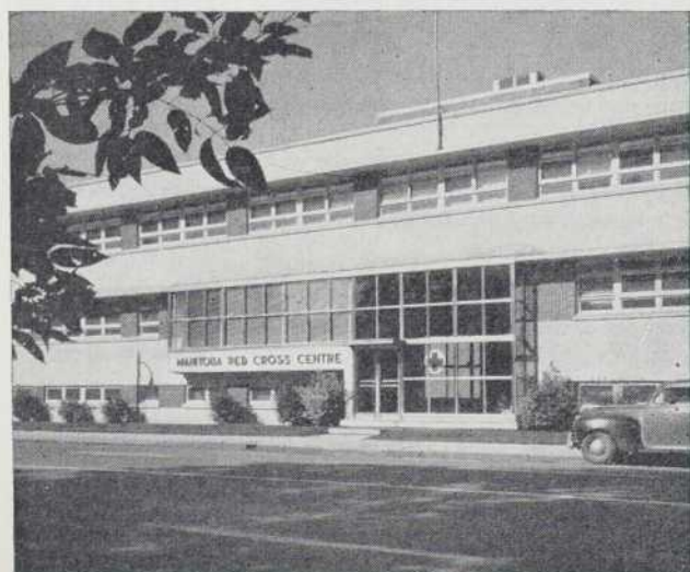
L'entrée et les fenêtres du nouveau Centre de la Croix Rouge manitobaine, rue Osborne, à Winnipeg, sont en acier inoxydable au nickel. Fabricant: Dominion Bronze and Iron Ltd., Winnipeg. Architectes: Moody and Moore, Winnipeg.
