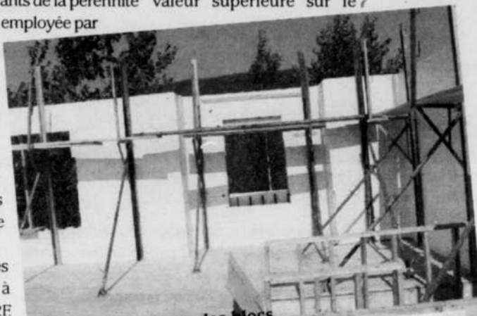
L'étape du montage des blocs.
