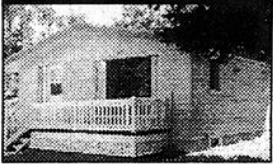
Rue du Couvent: Chalet habitable à l'année. Entièrement rénové. Vendu meublé.
