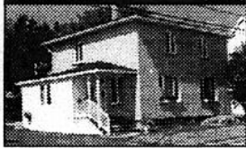
Rue Beaubien: Résidence 2 étages avec rénovations majeures. Terrain aménagé.
