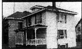
Rue Michaud: Résidence à prix économique. Plusieurs rénovations récentes.
