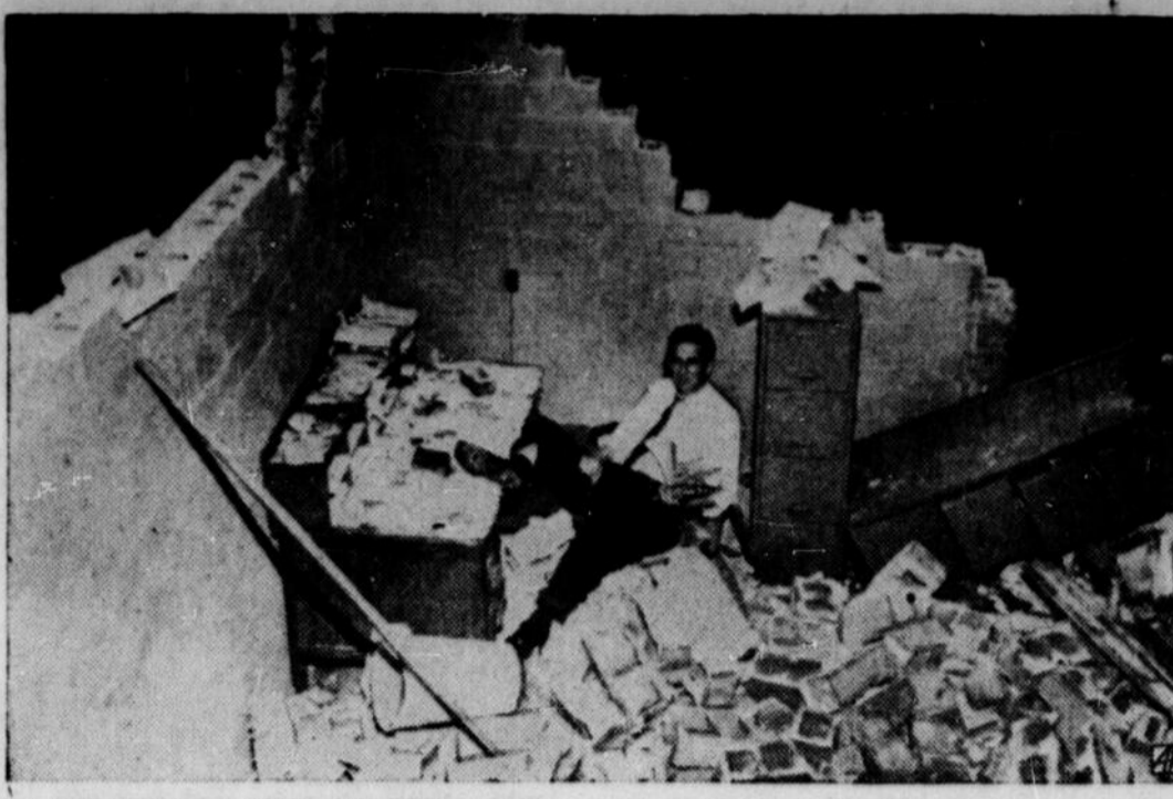
LA FERMETURE SUIVIT DE PRES L'OUVERTURE: M. T.-J. Smith, propriétaire d'une société occupant du transport aérien des marchandises, venait à peine d'inaugurer ses nouveaux bureaux qu'un tornado
