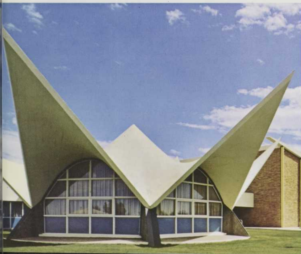
Toit de béton en forme de paraboloïde hyperbolique à l'école W. R. Myers, Taber, Alberta.
