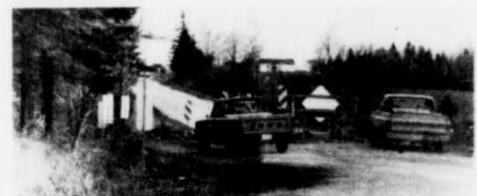
Des équipes de travail procèdent au nivellement de la route et à l'installation de nouveaux pontceaux.
