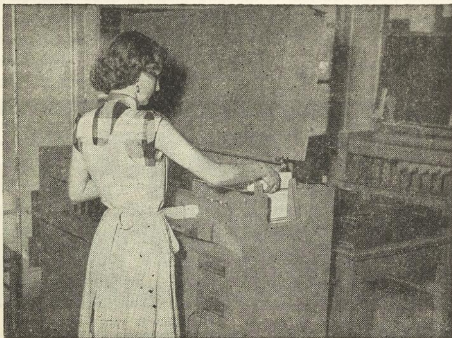
La trieuse-compteur électronique (système Bull) qui passe 700 cartes à la minute au cours du présent recensement français
