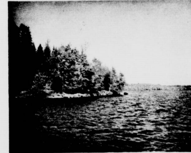
Le contrefort de l'île, où les Prud'homme ont construit le quai de pierres provenant de l'endroit même. L'exécution des travaux a pris deux longues années, et depuis, aucune des pierres n'a glissé malgré les degels de mars.
