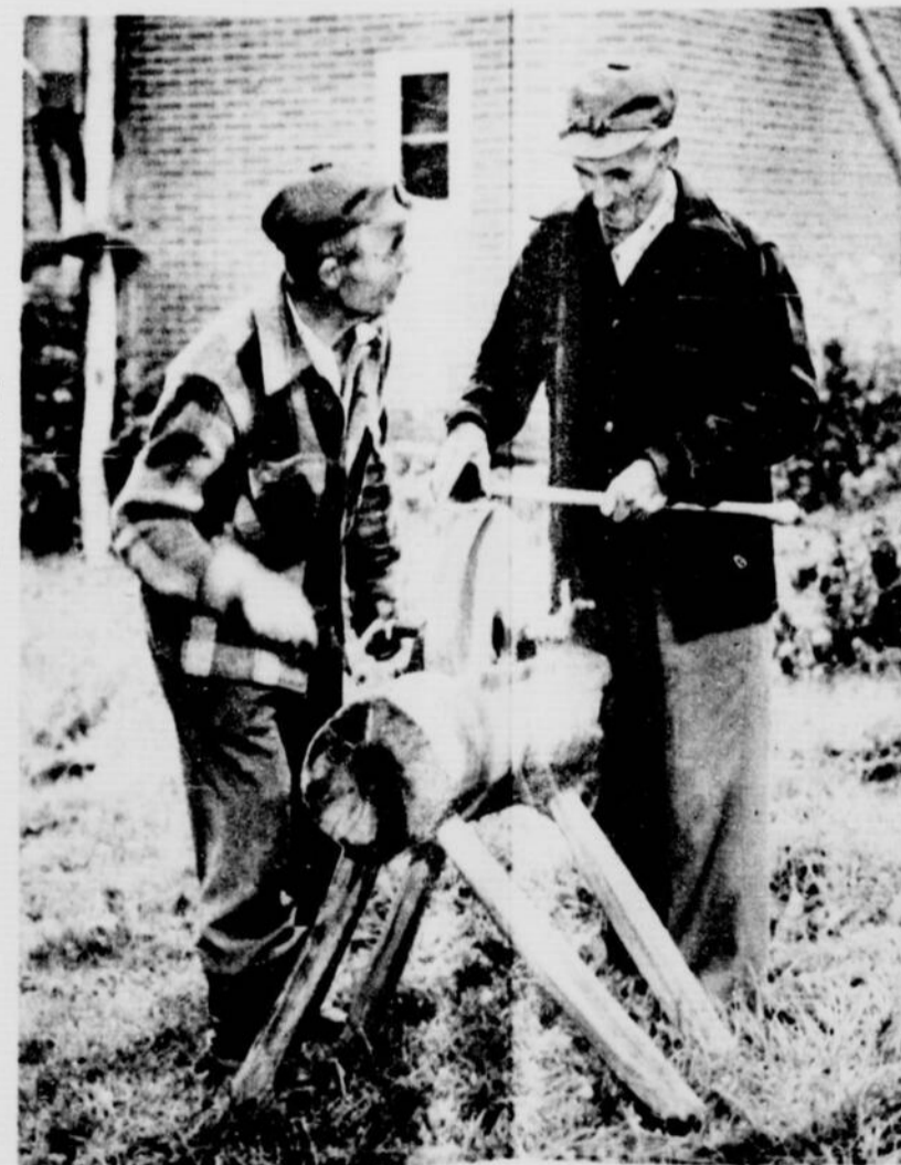
À l'aide d'une meule qui date d'un autre âge presque, James aiguise le tailant d'une de ces haches dont il façonne lui-même le manche. Son frère Louis tourne la manivelle et lit dans les yeux du grand frère s'il faut tourner plus vite ou ralentir. La hache coupera comme un rasoir.
