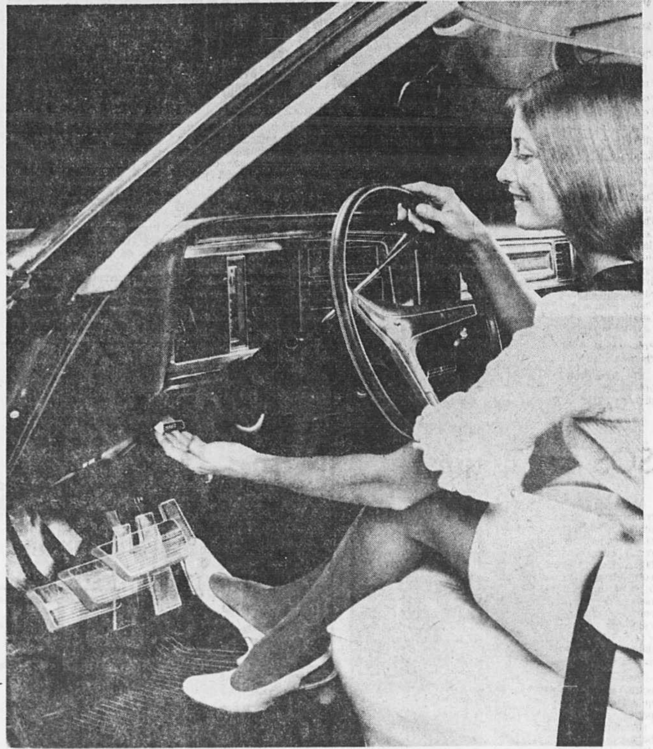
Les Pontiac 1974 proposent aux conducteurs de petite taille une nouvelle option: des pédales réglables. Ce nouvel élément de confort et de commodité permet au conducteur de faire varier de quatre pouces la position des pédales des freins et de l'accélérateur. La nouvelle option de Pontiac augmentera le confort des conducteurs qui pourront régler les pédales suivant leur taille ou pour changer de position afin de réduire la fatigue des longs voyages.
