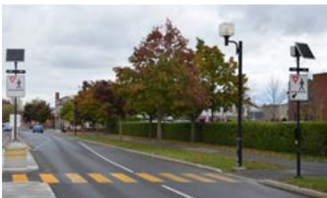
Fig. 19 - Passage piéton non contrôlé entre deux intersections
