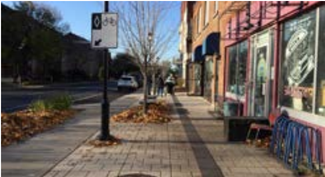
Fig. 9 - Trottoir avec banquette
