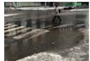
Fig. 48 - Accumulation d'eau à une abaisseée de trottoir
