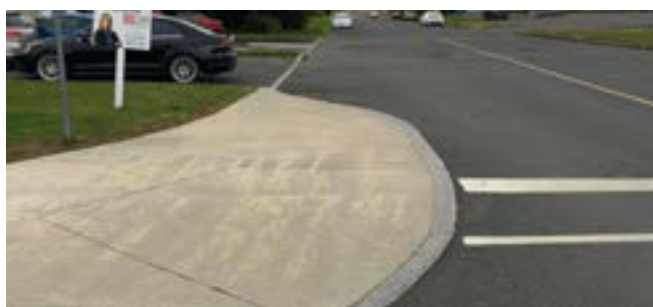
Fig. 25- Saillie non connectée à un réseau de trottoir et passage piéton contrôlé
