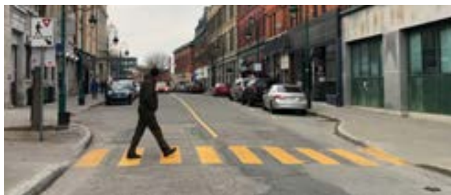
Fig. 26 - Saillies et passage piéton aménagés entre deux intersections
