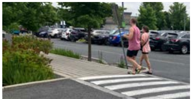
Fig. 29 - Passage piéton surélevé et trottoir dans un stationnement
