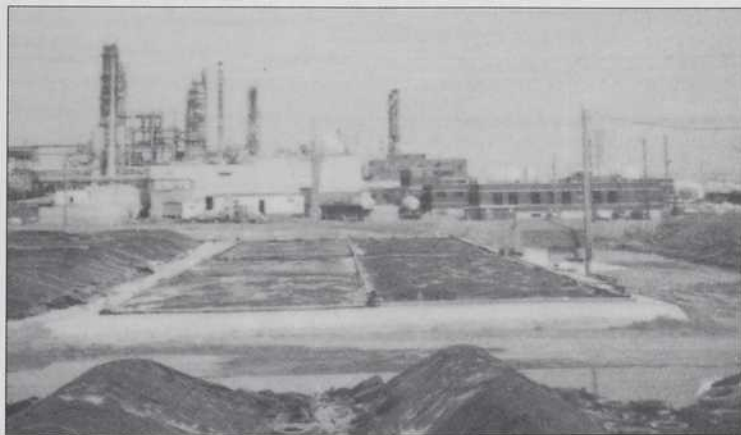
La terre, traitée grâce au procédé de biodégradation de Shell, sera bientôt assez décontaminée pour servir au remblayage.
