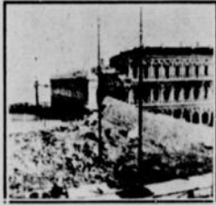
Les débris du campanile après son effondrement
