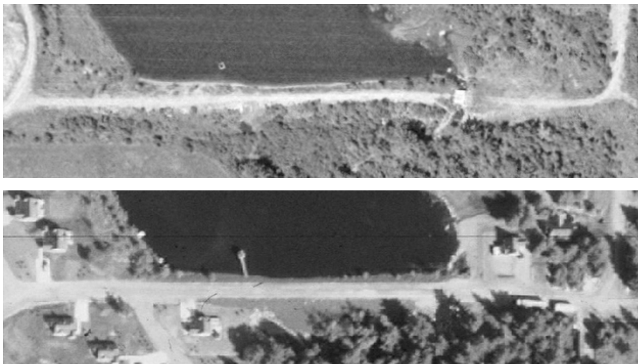
Figure 13. Le seuil par où l'eau courante du lac est évacuée (à droite) et le puits de béton contenant le mécanisme contrôlant le drain de fond (vers la gauche), en 1979 et en 1988. Détails de deux photographies aériennes (voir aussi en annexe la comparaison 1979-1988 plus large).
