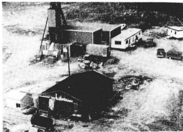
La mine Kierens a terminé en 1990 sa première année complète de production commerciale. Sa production de 14 844 onces d'or a permis à Aur de gonfler à plus de 11 M$ ses revenus bruts au Québec l'année dernière. Sur la photo, le puits de service de la mine.
