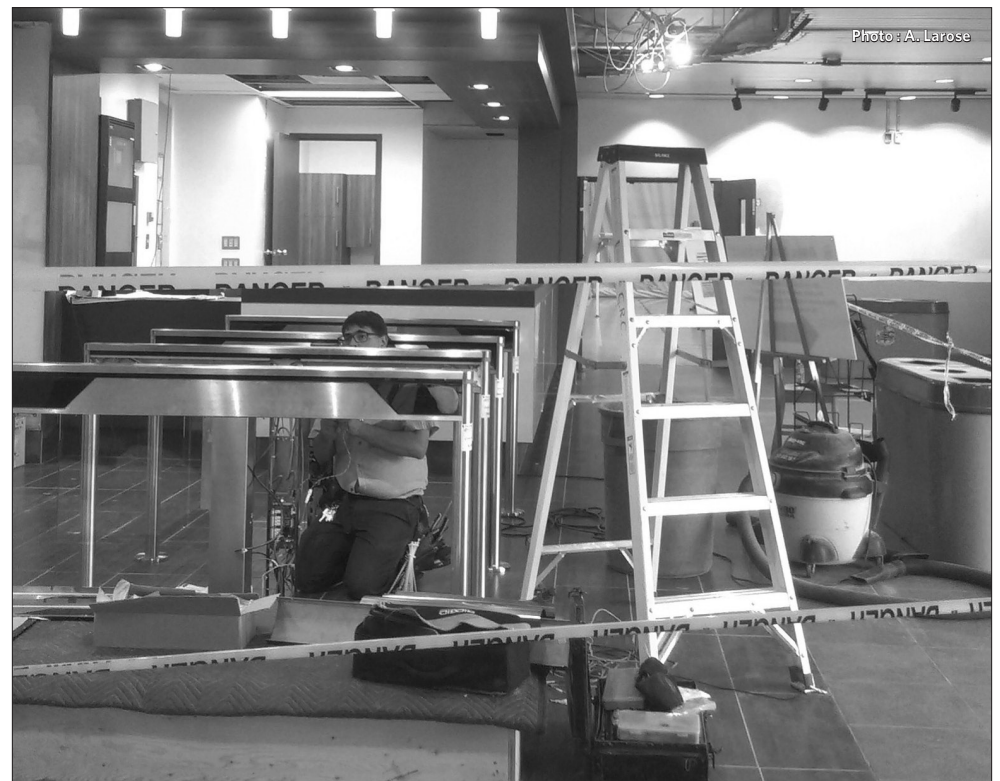
La réception du CAPS en cours de travaux.
