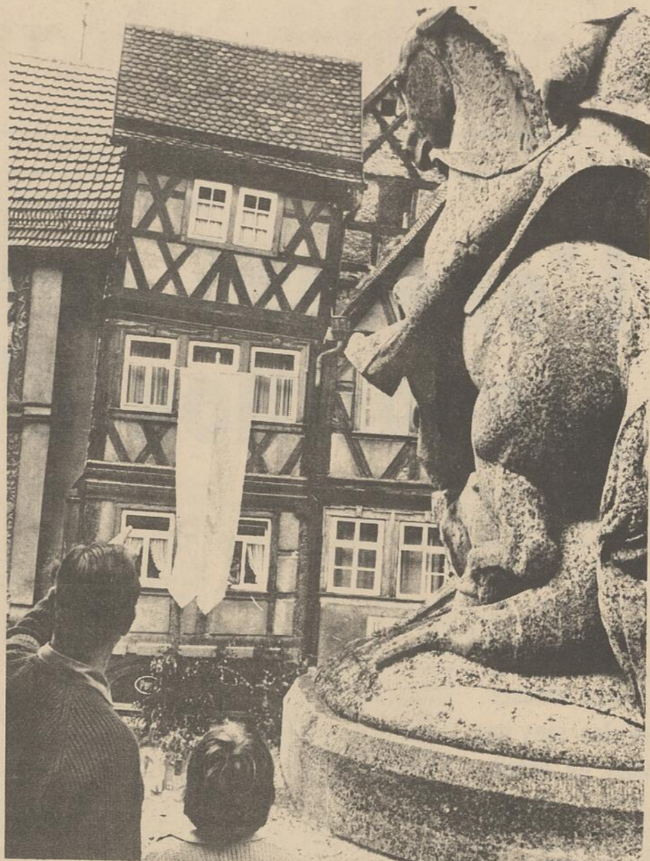
UNE CONCURRENTE DE LA TOUR DE PISE: Cette maison penchée sur la place du marché de la petite ville d'Ochsenfurt-sur-le-main fête un curieux jubilé. Il y a sept cent ans exactement les maçons oublièrent en construisant le mur de droite d'encastrement un élément de colombage de 23 cm d'épaisseur. Ni les habitants de la maison ni les autorités municipales n'ont jamais envisagé sa démolition, bien que les maçons n'aient pas précisément respecté les canons de la beauté architecturale. Seuls les locataires de l'étage du dessus sont un peu gênés: le plancher, les meubles sont inclinés et les assiettes s'obstinent à rouler sur la table. Or, on apprend que la maison s'est encore affaissée de 2 cm. Les voisins alarmés craignent qu'elle ne leur tombe un jour sur la tête.
