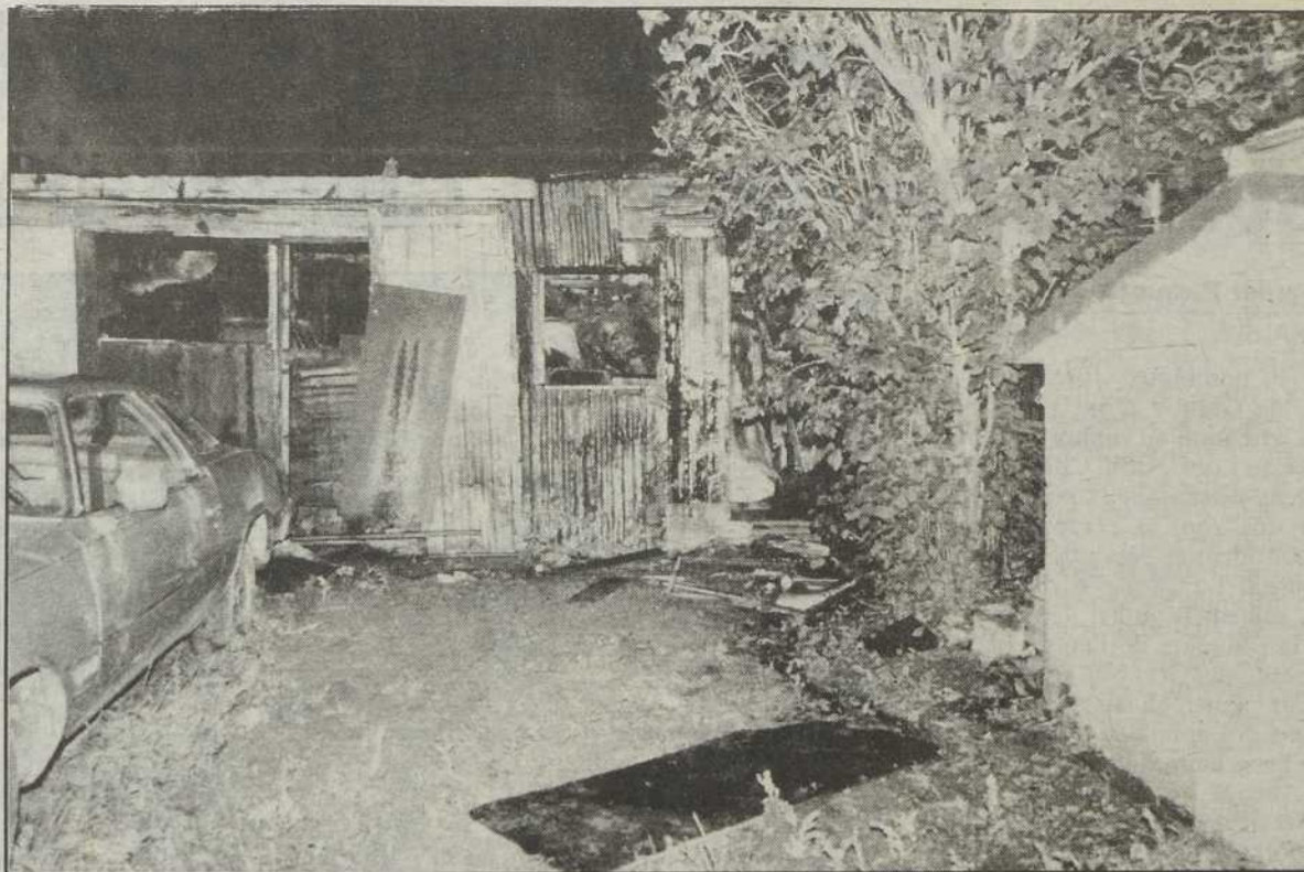
Des incendies se sont aussi déclarés dans une remise et une maison en rénovation.
