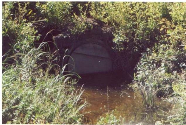
Figure 16. Les quelques aboiteaux construits dans le haut-marais laissent l'eau des marées et de la pluie s'évacuer grâce à ce type de drain muni de clapet.
